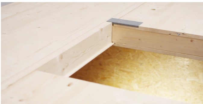
Grande enchevêtrure avec chevêtre et plaque en acier
