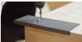
Grande enchevêtrure avec chevêtre et plaque en acier
