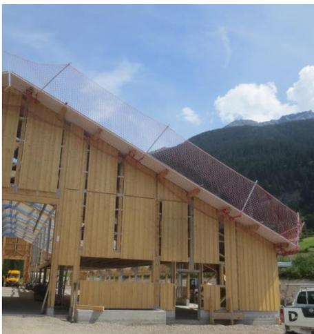
Giebelseitig ist ein konventioneller Seitenschutz gemäss Factsheet 33017 oder ein Seitenschutz mit Auffangnetzen gemäss Factsheet 33028 zu montieren.
